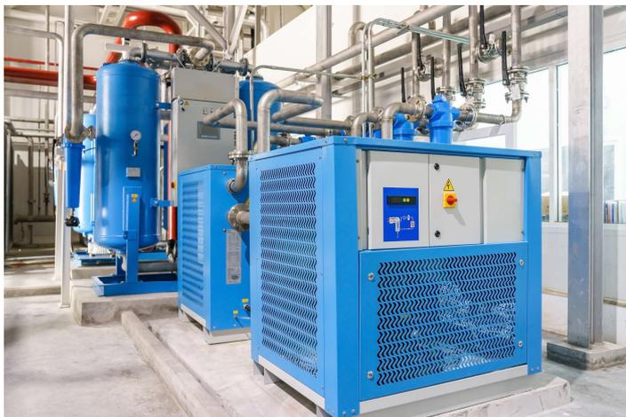
様々なメーカーがあるエアコンプレッサの最適化運転を実現させる為、流量監視と、その情報を基にした一元管理を実施。各所に設置されているコンプレッサの能力に応じて最適な稼働条件を演算し、工場全体での最適化を実現させた。分散設置と様々なメーカーであったため、それらを一元管理する為のシステムとデータ受発信の仕組みを構築
